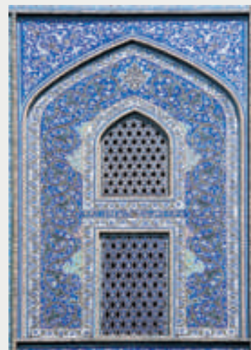
DETALL DEL REVESTIMENT EXTERIOR DE LA MESQUITA DE L'IMAM
